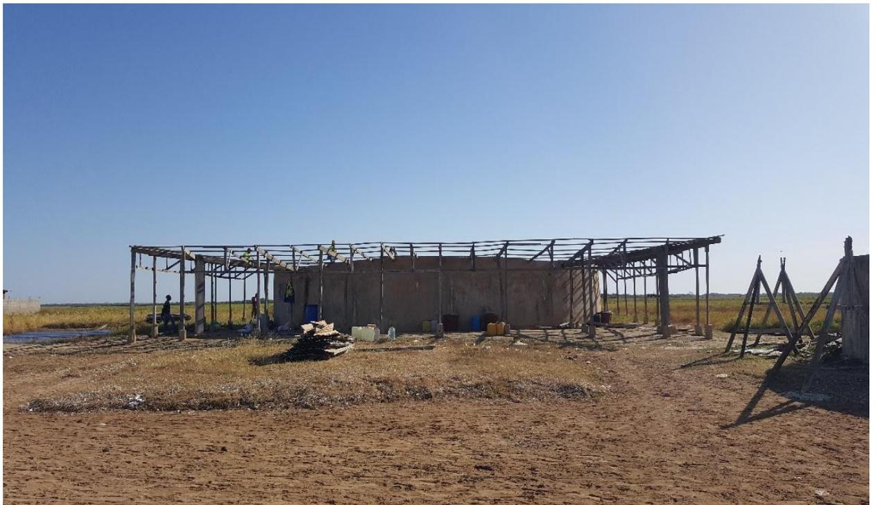
Photo 21 La charpente à nue, prête à être restaurée avant la pose de la nouvelle couverture
